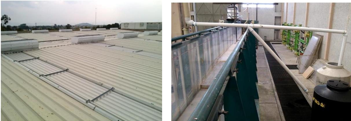
Figura 17. Sistema de captación e intercepción de agua pluvial
